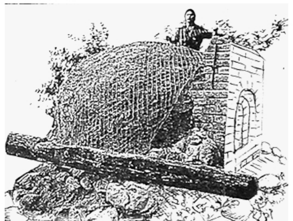
Bewehrung in Strohlehmpackung
